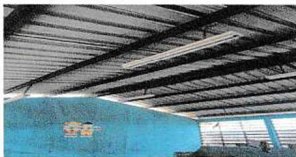
Foto 3: Sustrucción de lámparas aula 1.
