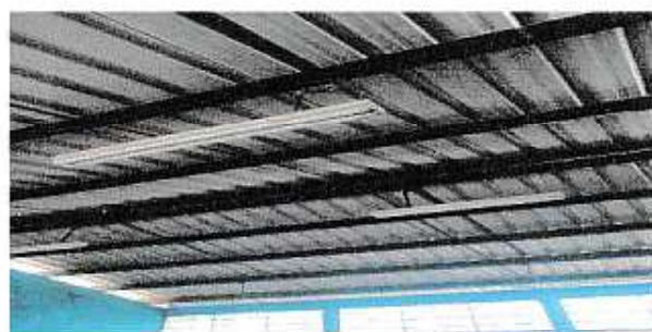
Foto 4: Sustrucción de lámparas aula 2.
